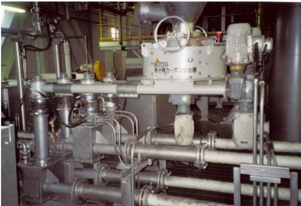
**Abbildung 1:** 4 Einzelleitungen hinter 4-fach Schnecken-Verteilerbox und Injektoren (vergl. Abb. 2c) mit 2 Gebläsen
